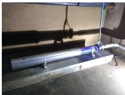
Pompe neuve posée à l'UPEP de la Grande Borne à Cérilly
