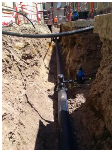
Pose d'une canalisation neuve Rue Mistaudin à Cérilly
