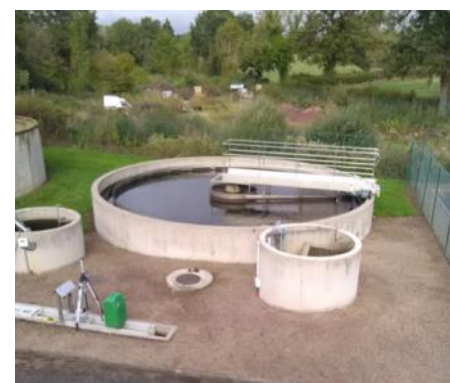
STEP (STation d'EPuration) de Cérilly
