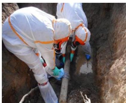
La commune de Cérilly dispose d'un important linéaire de canalisations d'eau potable en amiante-ciment. Interdit depuis 1997, ce matériau a la particularité d'être très sensible à tout mouvement de terrain ou changement de pression.
