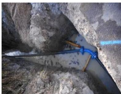
**Lieu-dit Les Bourses** : pose de 900 ml de conduite sous accotement (ancienne canalisation en domaine privé) et renouvellement d'un branchement. Les travaux ont été effectués en interne par les équipes du SEA. Pour cette année, 91% des fuites réparées sur la commune proviennent d'une rupture de canalisation en amiante-ciment. À ce jour, il reste environ 18 km de conduite de ce matériau.
